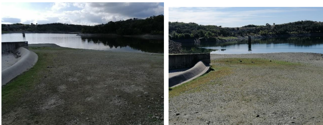
Fotos Anabela Coimbra: Barragem de Nogueira em Bragança, zona da Terra Fria, em 22/09/2020(foto da esquerda) e em 20/09/2021 (foto da direita).
